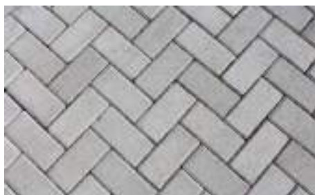
Figura 10 - Piso intertravado de concreto
